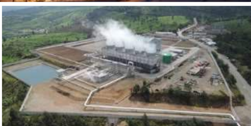
Bilde oppe: Kullkraftverket i Longyearbyen, Svalbard. Bilde nede: Geotermisk kraftverk Indonesia.
