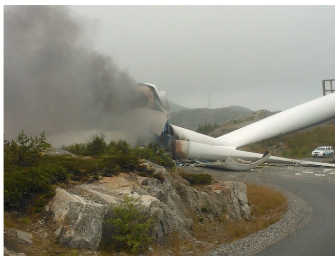
Turbinen "Demo 1" begynte å brenne da den deiset i bakken under en kontrollert riving. (Bilde: InTurbine AS)
