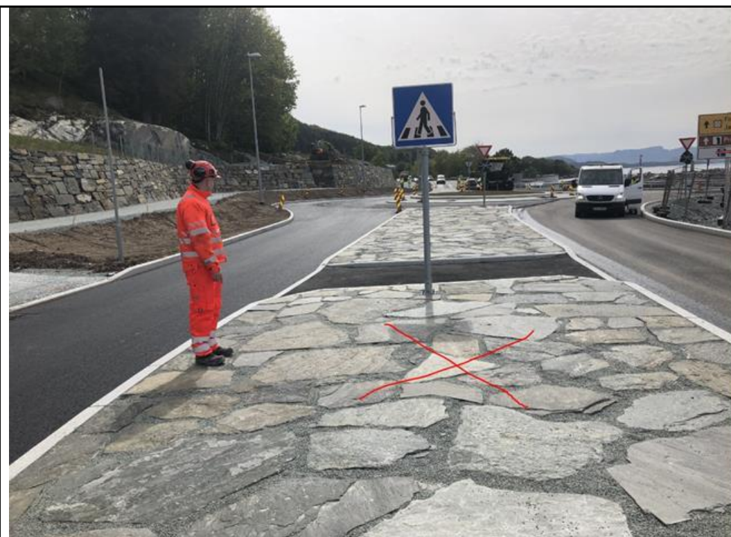
Figur 2: Sandfang og vaskepass under ferdig etablert veg.
