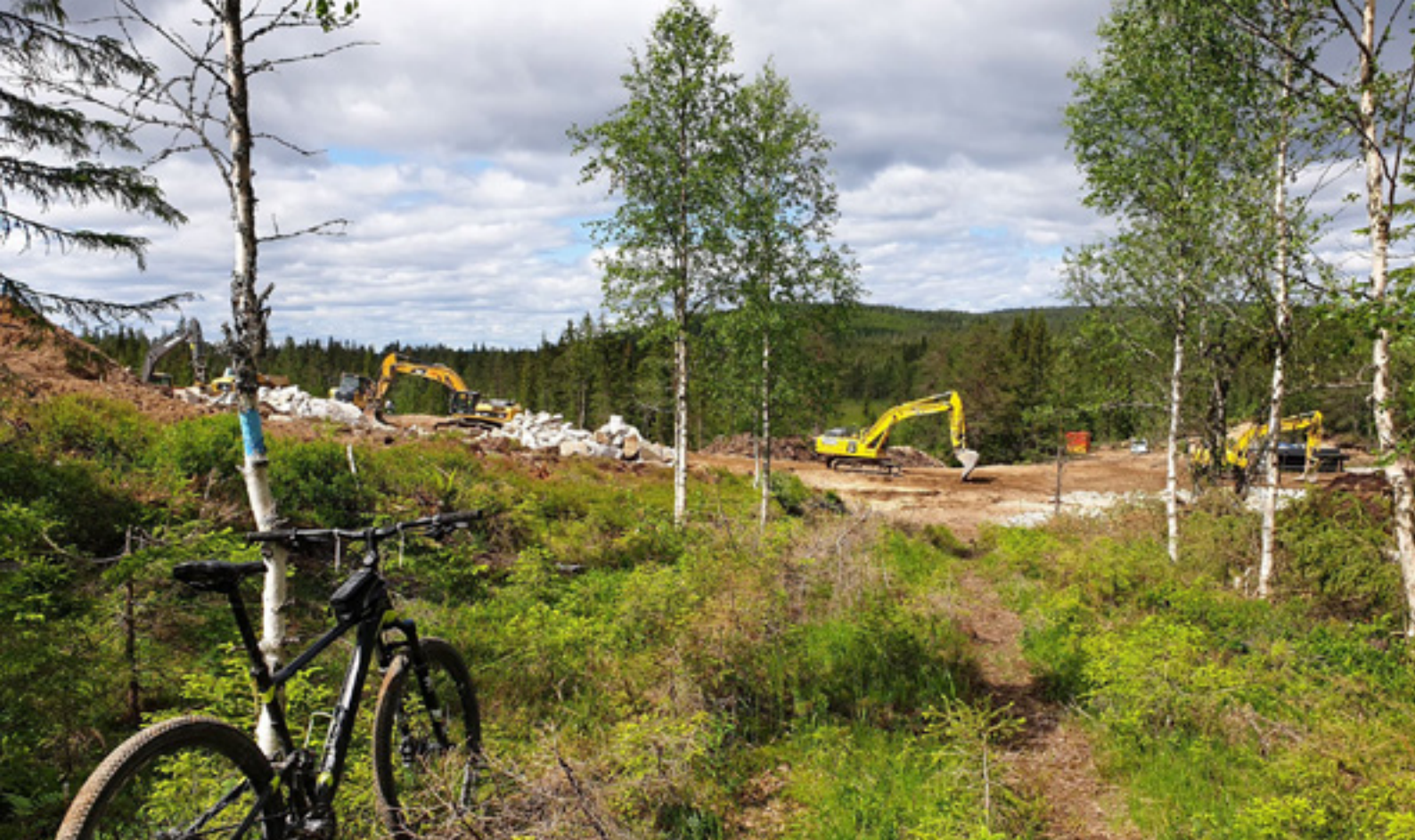
Anleggsarbeid i Finnskogsleden. Foto: Gry Schjøll Hansen
