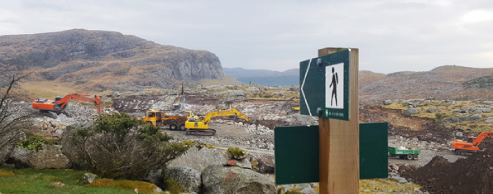
Her går en populær og mye brukt tursti i et av Nord-Jærens flotteste turterreng, helt til vårt kjære NVE fant ut at her ville de heller ha et vindkraftverk... Allemannsretten gjelder ikke i industriområder. Anleggsvirksomhet ved Varadajell vindkraftverk, Sandnes kommune, Rogaland
